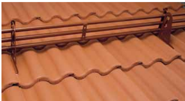
Bild 19. Snörasskydd grind komplett monterad på tak.
